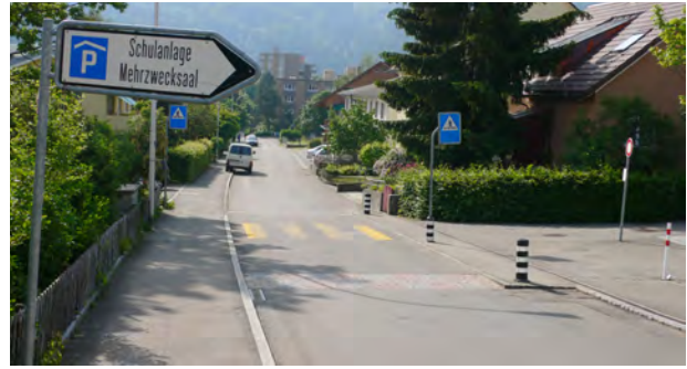
Abb. 5.12 und 5.13 Tempo-30-Zone Schlieren Köniz mit vertikalem Versatz beim Schuleingang. Der im Bild noch sichtbare Fussgängerstreifen wurde unterdessen nicht mehr erneuert, weil er unzweckmässig ist.
