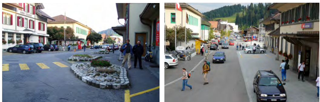
Abb. 4.7 und 4.8 Langnau, Bahnhofplatz vorher und nachher
